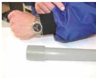
9. Låt torka. Torktid 1h/1bar vid 20°C för provtryckning med vatten. 24 h fullt driftstryck.
