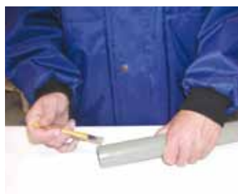
6. Lägg på lim längsgående både på rör och rördel
