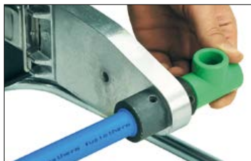
Oppvarming av rør og rørdel
