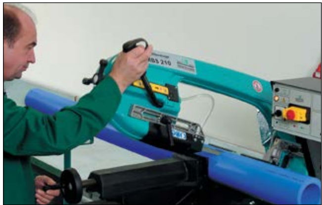
Kapp 160 mm røret i riktig lengde før sveising.
