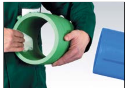
Rengjør el-sveisemuffens innside
