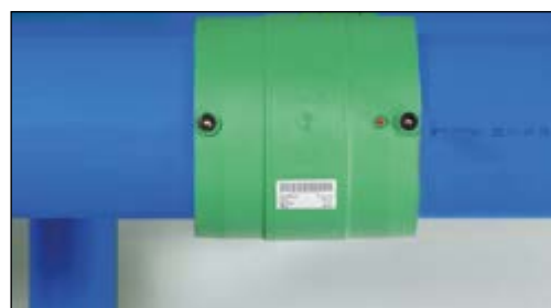
Den andre rørenden skrapes og skyves inn i muffen
