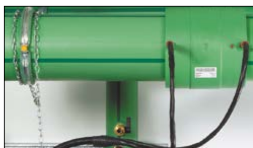
Still sveisemaskinen på riktig dimensjon. Start sveisingen og overvåk hele prosessen. Overhold avkjølingstiden.
