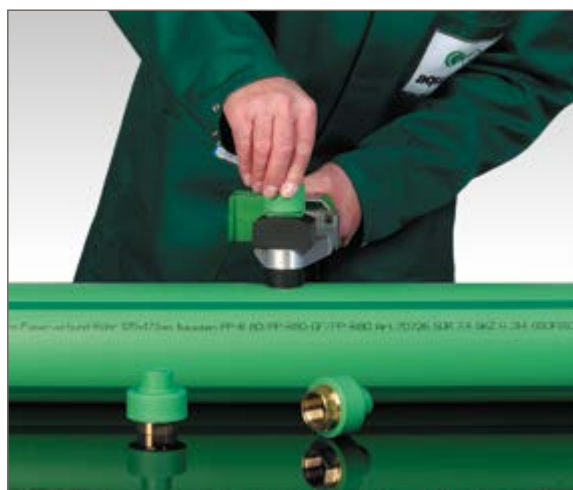
Oppvarming av rør og rørdel
