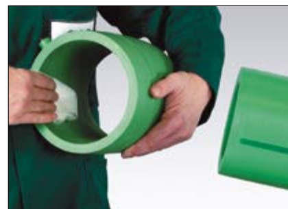
Rengjør el-sveisemuffens innside
