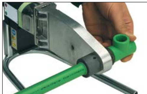
Oppvarming av rør og rørdel
