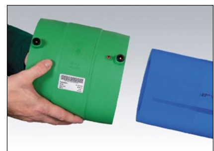
Trykk el-sveismuffen inn på rørenden
