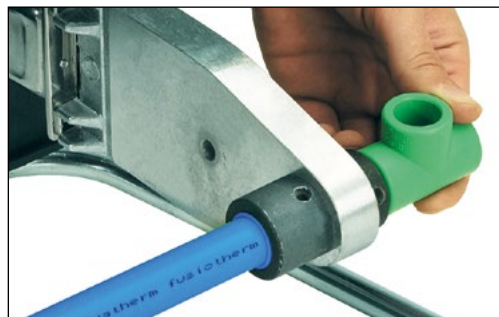
Oppvarming av rør og rørdel
