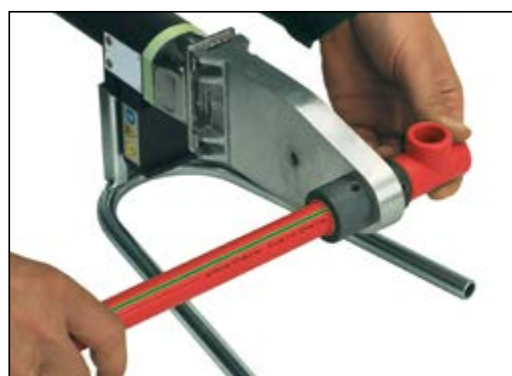
Oppvarming av rør og rørdel.
