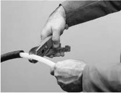
1. Kutt av ytterrøret og klipp av PEX-røret. Se til at ca. 5 cm av PEX-røret er fritt.
