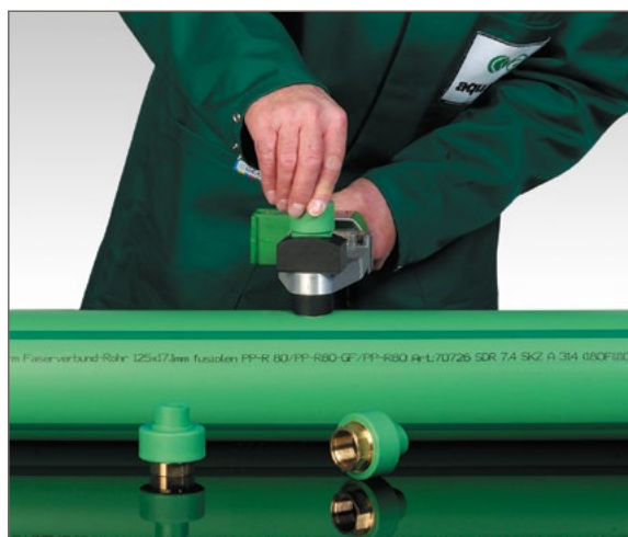
Oppvarming av rør og rørdel
