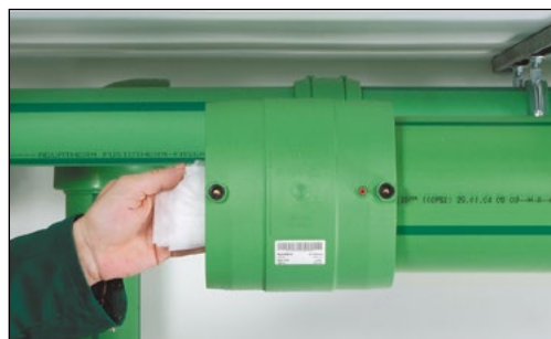
Rengjør el-sveisemuffen på nytt
