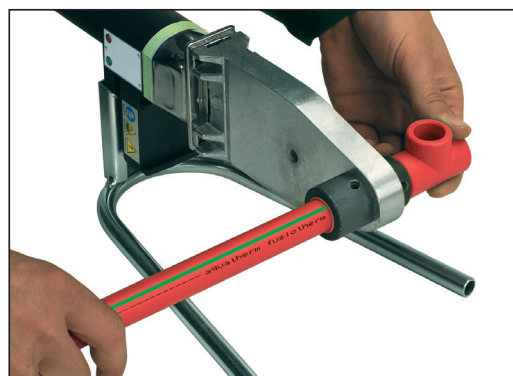
Oppvarming av rør og rørdel.
