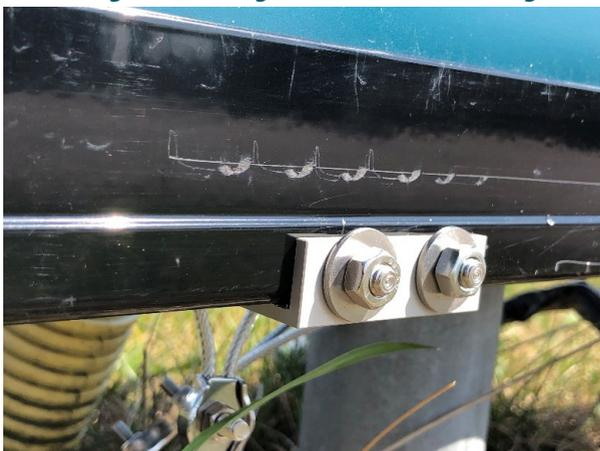
5. Ziehen Sie die Sicherungsmuttern vorsichtig mit dem Schraubenschlüssel fest, um die Augenschrauben zu fixieren.
