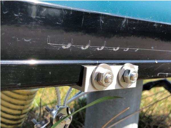
8. Ziehen Sie die Sicherungsmuttern vorsichtig mit dem Schraubenschlüssel fest, um die Augenschrauben zu fixieren.
