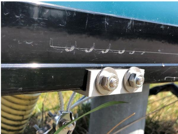
5. Serrez doucement les contre-écrous à l'aide d'une clé en gardant le boulon à œil fixe.
