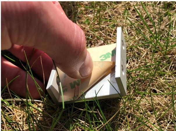
4. Montez le support à l'emplacement prévu sur le profil inférieur.
