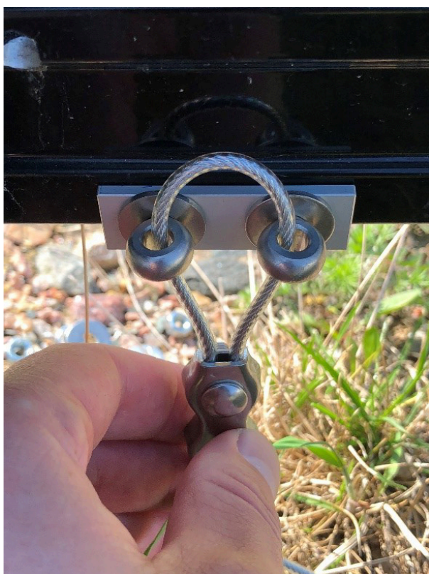
Rysunek 15: Montaż podkładek i śrub oczkowych
