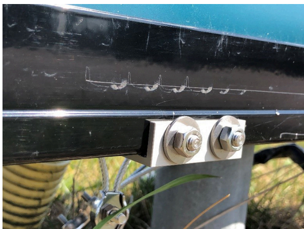
Rysunek 16: Zakładanie podkładki i dokręcanie nakrętek zabezpieczających
