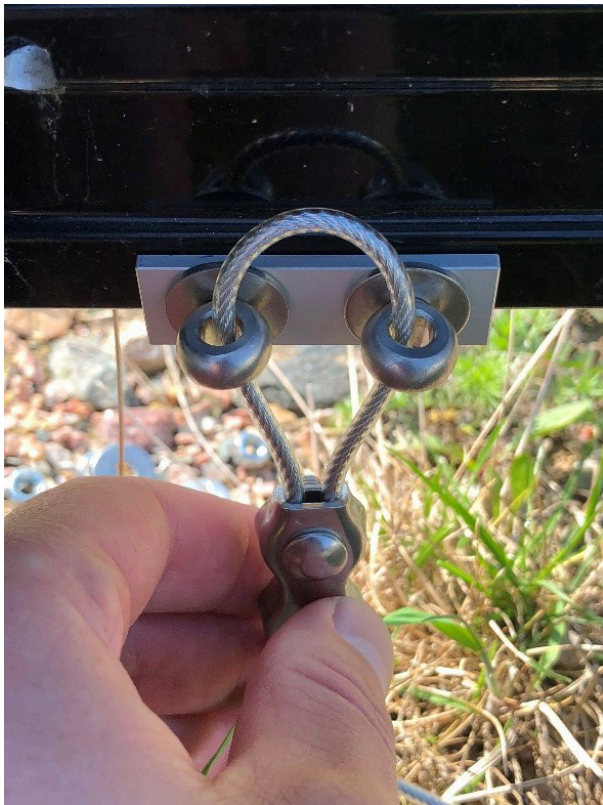
Rysunek 10: Montaż podkładek i śrub oczkowych
