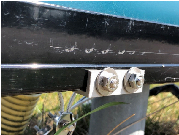
Rysunek 11: Montaż nakrętek samokontrujących z podkładkami
