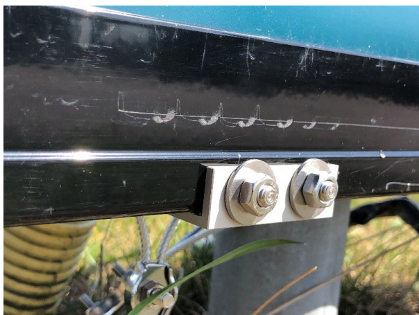
Rysunek 11: Montaż nakrętek samokontrujących z podkładkami
