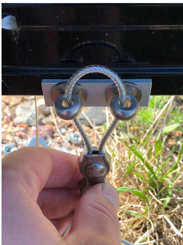
Rysunek 15: Montaż podkładek i śrub oczkowych
