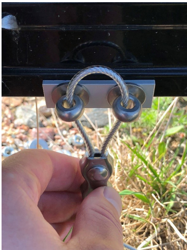
Rysunek 10: Montaż podkładek i śrub oczkowych
