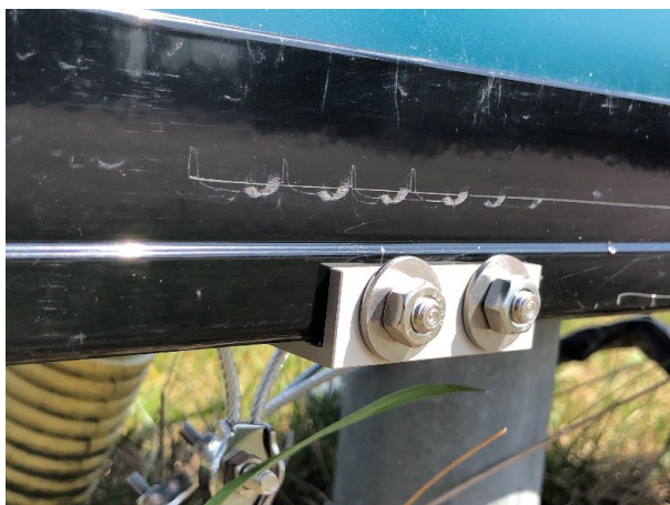
Rysunek 16: Zakładanie podkładki i dokręcanie nakrętek zabezpieczających
