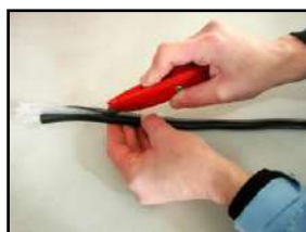
1. Tagliare i primi 10 cm del rivestimento dei cavi
