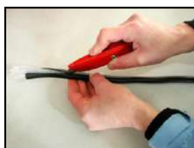
1. Couper la gaine des câbles sur une longueur de 10 cm environ.
