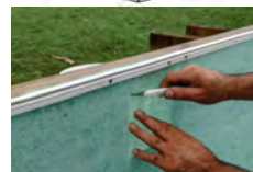
Fixing of the skimmer joint Fijación de la primera junta del skimmer Fixation du 1er joint de skimmer Befestigung der ersten Dichtung des Skimmers Fissaggio del primo giunto dello skimmer Bevestiging van de eerste pakking van de skimmer Fixação da primeira junta do skimmer
