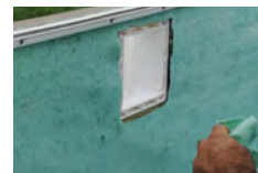
Fixing of the skimmer joint Fijación de la primera junta del skimmer Fixation du 1er joint de skimmer Befestigung der ersten Dichtung des Skimmers Fissaggio del primo giunto dello skimmer Bevestiging van de eerste pakking van de skimmer Fixação da primeira junta do skimmer
