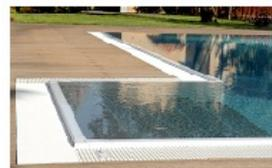
Toda la gama de liners de **RENOLIT ALKORPLAN** cumple las especificaciones de la norma francesa NFT 54-803-1, y se caracteriza por su gran resistencia a la alta presión ejercida por el agua y su flexibilidad de adaptación al vaso. Además, **RENOLIT**, como fabricante, da una garantía de estanqueidad de 10 años.
