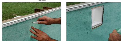
Fixing of the skimmer joint Fijación de la primera junta del skimmer Fixation du 1er joint de skimmer Befestigung der ersten Dichtung des Skimmers Fissaggio del primo giunto dello skimmer Bevestiging van de eerste pakking van de skimmer Fixação da primeira junta do skimmer
