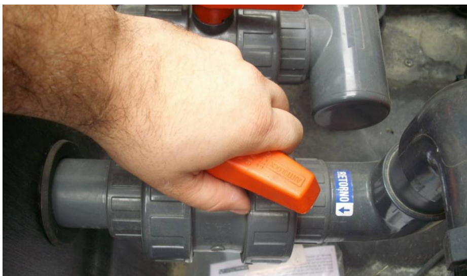
Fig. 23.- Cerrar la válvula de retorno.
