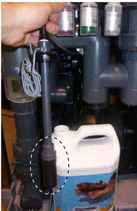
Figure 39 : Filtre à particules
