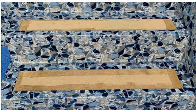
Aplicar cola de contacto en la parte trasera de la lámina, en la contrahuella y el borde exterior de la huella superior.
