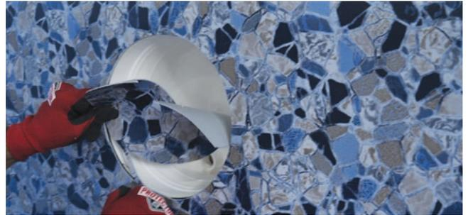
Buscar con los dedos la abertura de los accesorios empotrados en la estructura y cortar la lámina en forma transversal
