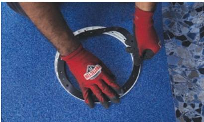
Colocar la segunda junta en el anillo exterior. Buscar con los dedos los orificios roscados para fijar los tornillos.
