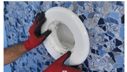
Pasar el cableado a través de la pared de la piscina, conectar incluyendo con las juntas correspondientes y finalizar la instalación.
