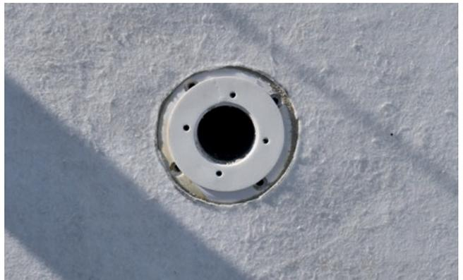
Una vez instalado, cortar el Geotextil alrededor de los accesorios presentes en el vaso de la piscina.
