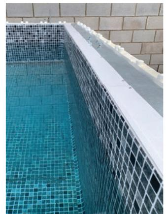
Perfil liner Hung horizontal: para nueva construcción
