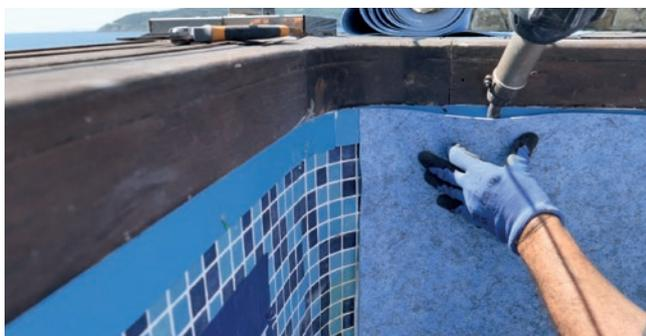
Primero fijar la lámina a los perfiles de PVC con puntos de calor cada 50 cm, de modo que quede en posición vertical.
