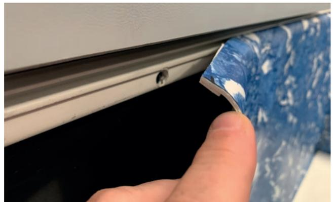
Colocar la lámina con la tira de 9mm dentro del perfil HUNG.
