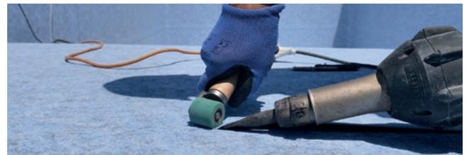
Las piezas de lámina en el suelo se pueden instalar mediante soldadura por solape (ver 4-2) o soldadura a testa (ver 4-3).
