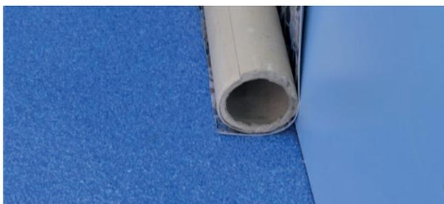
Dejar un espacio entre la lámina y la esquina de 90 grados formada por la pared y el suelo. Este retranqueo permitirá que la lámina alcance la tensión correcta durante el llenado de agua de la piscina. Una lámina reforzada tiene una tasa de alargamiento baja; sin este retranqueo, la lámina no se tensaría adecuadamente y crearía arrugas a lo largo de las paredes.
