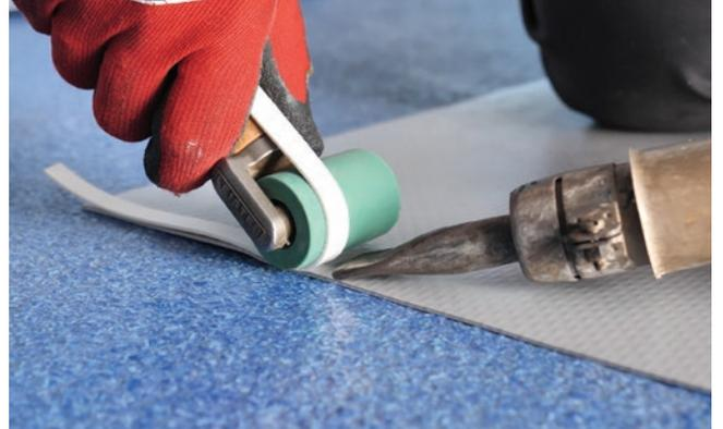
Soldar esta tira en la parte trasera del borde superior de la lámina que se va a instalar en la pared.
