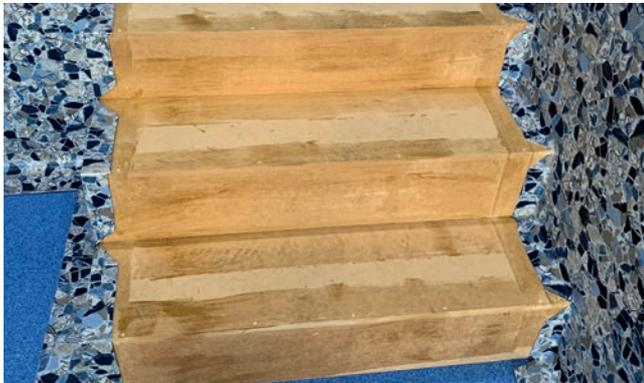
Aplicar cola de contacto en la parte trasera de la lámina y en las paredes alrededor de las escaleras.
