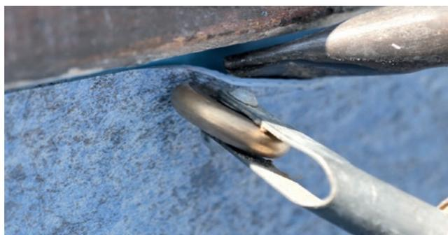
Realizar el segundo cordón de soldadura de la lámina sobre el perfil de PVC.
