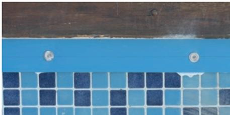
La distancia máxima entre 2 fijaciones no debe exceder los 20 cm. Más adelante veremos el proceso de soldadura con aire caliente de la lámina a los perfiles de PVC. La lámina quedará soldada de forma permanente a los perfiles.
