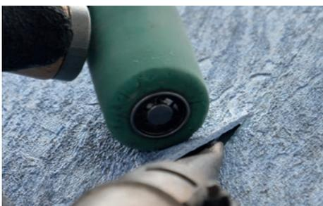
Este proceso solo se aplica al suelo de la piscina. En primer lugar, se pega al suelo una banda de soldadura de 15 cm de ancho a intervalos regulares. El Geotextil compensará la diferencia de nivel entre el soporte y la banda de soldadura para que toda la superficie quede plana. A continuación, las 2 piezas de lámina armada se sueldan a testa con 2 cordones de soldadura para garantizar una soldadura cuyo ancho total será de 3 cm.
