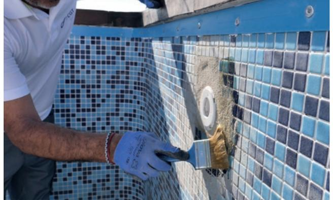
Aplicar cola de contacto alrededor de los accesorios, debajo de los perfiles de fijación y en las esquinas.
