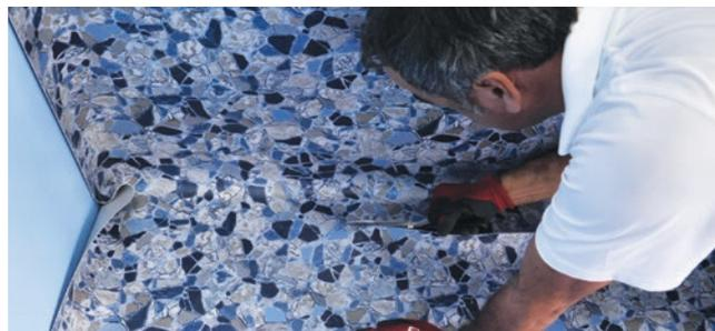
Asegurarse de tener un solape de al menos 10 cm en la parte inferior de la pared sobre el suelo. Fijar este solape en la parte baja de la pared al suelo con remaches de acero inoxidable cada 20 cm. Posteriormente se soldará la lámina del suelo sobre este solape.
