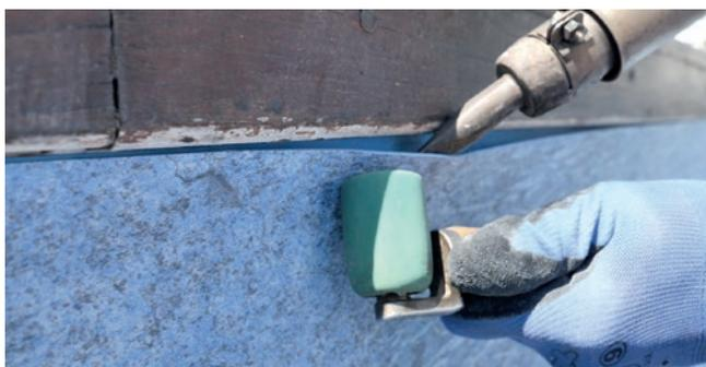
Realizar el primer cordón de soldadura de la lámina sobre el perfil de PVC.
