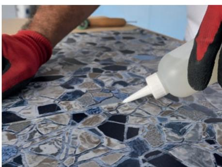
En el caso de una soldadura por solape, es necesario aplicar PVC líquido a lo largo del cordón de soldadura (25 g/metro lineal) para conseguir un sellado perfecto.
