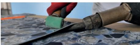
Un cordón de soldadura recto debe tener un ancho mínimo de 2 cm. La velocidad de soldadura es de aproximadamente 50 cm/min. En algunas zonas, como las esquinas, los solapes pueden ser inferiores a 2 cm pero nunca inferiores a 1 cm.
