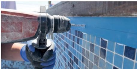
Los perfiles de PVC deben fijarse mecánicamente al soporte con remaches de acero inoxidable o usando tacos con tornillos de acero inoxidable.
