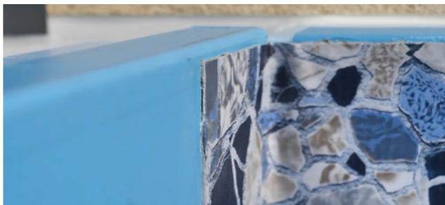
Asegurarse de tener un solape vertical de al menos 10 cm en ambos extremos de la lámina para tener suficiente material a la hora de soldar las piezas.
