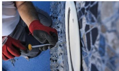
Perforar la lámina con un destornillador o una herramienta similar. Atornillar el anillo exterior del accesorio. Cortar la lámina a ras en el interior del accesorio.
