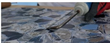
Todos los cordones deben verificarse con un comprobador metálico en toda su longitud para detectar puntos débiles o falta de soldadura. En caso de descubrir fallos o trozos sin soldar, será necesario volver a soldar estas zonas de manera adecuada.
