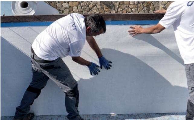
Posicionar y fijar el Geotextil a las paredes para conseguir una superficie completamente plana. No superponer las piezas de Geotextil.
