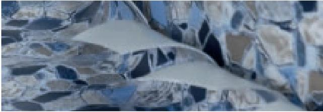
Es necesario cortar la lámina de la pared en su parte inferior de acuerdo con la forma de la pared.
