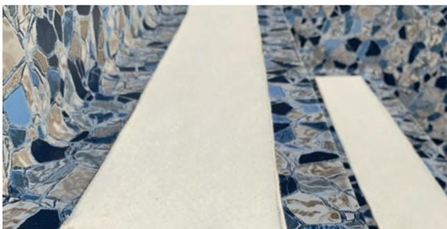
Instale una pieza de Geotextil cortada a la dimension correcta en la huella para que toda la superficie quede plana.
