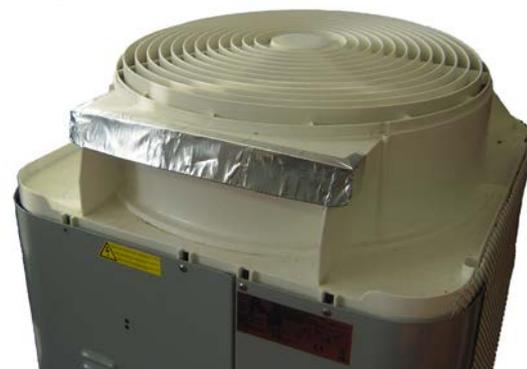
**4** Otturare l'uscita dell'aria con lo scotch in alluminio
