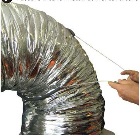
**8** Passare il cavo intorno al condotto, posizionare la guaina di plastica in modo che protegga il condotto di soffiaggio
