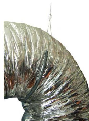
**10** Fissare il cavo al soffitto con l'occhiello all'altra estremità del cavo
