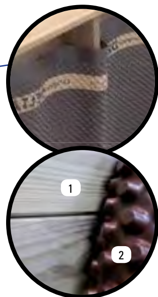
1- Armazón de madera 2- Rollo de protección y drenaje alveolar de PEHD
