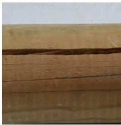
Cracks/Grietas/Fente/Risse/ Crepe/ Barsten/Fendas
