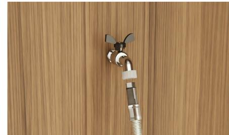
Raccordez le tuyau d'alimentation au robinet et serrez à la main en place. En utilisant une clé ou des pinces, tournez de 180° supplémentaires pour le fixer. Évitez de serrer excessivement.
