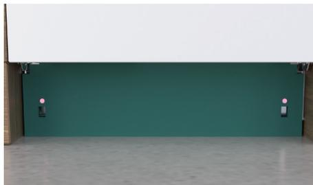
Assurez-vous que la rotation de porte n'est pas obstruée avant de fixer les feuilles d'isolant acoustique sur la plaque de plinthe métallique à l'aide du ruban adhésif double face fourni.
