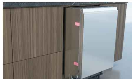
Sélectionnez la largeur de pièce d'espacement souhaitée et coupez-la à la taille appropriée. Retirez le revêtement de l'adhésif et placez deux pièces d'espacement sur chaque côté du produit.
