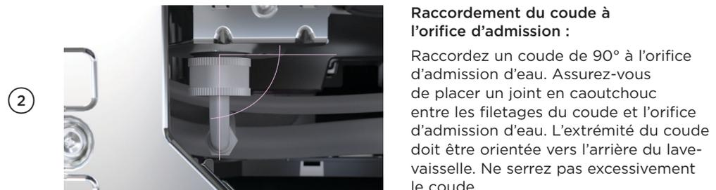
**Raccordement du coude à l'orifice d'admission :**
