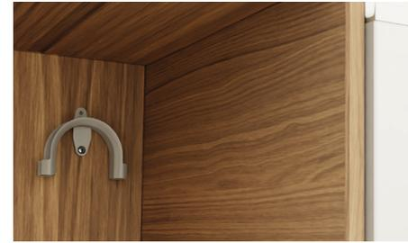
Installez le support de tuyau d'évacuation sur le mur arrière, aussi près que possible du dessous du comptoir. Reportez-vous à 'À prendre en considération pour les raccordements de plomberie et d'alimentation électrique' pour les hauteurs d'installation minimales.
