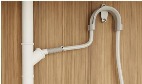
Faites passer le tuyau dans le support de tuyau d'évacuation avant d'insérer le collier de serrage sur le tuyau et de l'installer sur le siphon d'évier. Fixez au siphon à l'aide du collier. Assurez-vous que le tuyau s'insère en ligne droite dans le siphon.
