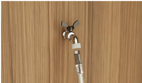
Raccordez le tuyau d'alimentation au robinet et serrez à la main en place. En utilisant une clé ou des pinces, tournez de 180° supplémentaires pour le fixer. Évitez de serrer excessivement.
