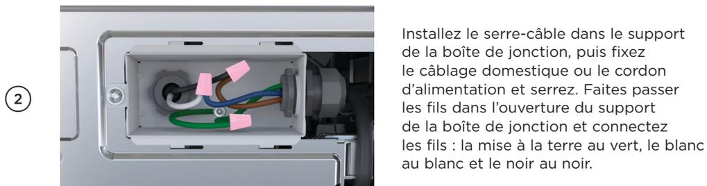
Installez le serre-câble dans le support de la boîte de jonction, puis fixez le câblage domestique ou le cordon d'alimentation et serrez. Faites passer les fils dans l'ouverture du support de la boîte de jonction et connectez les fils : la mise à la terre au vert, le blanc au blanc et le noir au noir.
