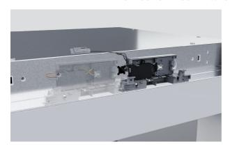
4. Bewegen Sie das Sensorgehäuse, um den gegenüberliegenden Hallsensorclip auf die Mitte des Schranks auszurichten.
