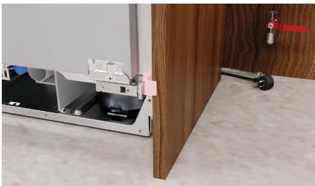
Poussez le produit dans l'alcôve tout en tirant sur le tuyau et le cordon d'alimentation. Assurez-vous que les jauges touchent l'extrémité de l'alcôve, que le tuyau n'est pas entortillé et que le cordon d'alimentation demeure libre et démêlé.
