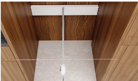
Au besoin, installez une pièce d'espacement à l'arrière de la cavité pour ajuster la profondeur à 24 po (610 mm).
