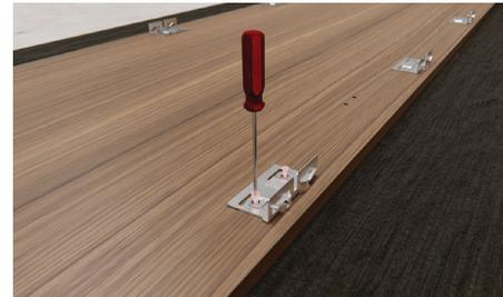
Fixez les supports latéraux en utilisant deux vis par support. Assurez-vous que les supports latéraux soient installés solidement et que les fixations soient bien droites.
