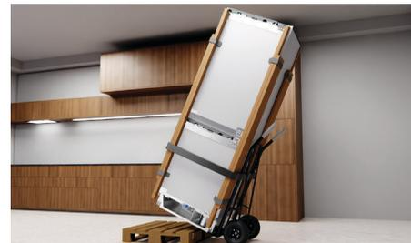
Inclinez le produit sur le chariot manuel et retirez la palette. Déplacez le produit jusqu'à l'emplacement d'installation. Retirez et mettez au rebut les montants de coin.
