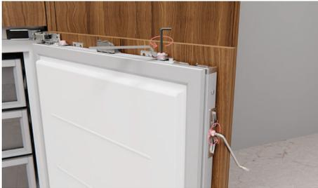
Retirez le diviseur de débit et le support de panneau avant de retirer toutes les vis latérales du panneau de porte, ainsi que la rondelle M8 et l'écrou. Soulevez le panneau vers le haut et l'extérieur pour le retirer.
