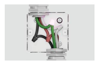
6. Conecte el cable de conexión a tierra verde del horno al cable de conexión a tierra (verde) de la caja de conexiones. No conecte el cable de conexión a tierra verde al cable neutro (blanco) en la caja de conexiones.
