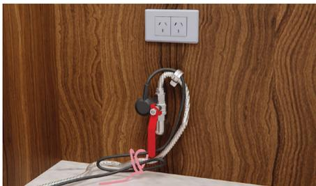
Se necessario, avvolgere un cavetto attorno al flessibile e al cavo elettrico per mantenerne la posizione e ridurre la formazione di grovigli sul retro del prodotto.
