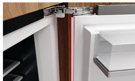
Posizionare il profilo corto sul lato con cerniera del prodotto e farlo scorrere fino ad incastro. Se è presente un vuoto, rimuovere e regolare di nuovo la posizione delle staffe laterali.
