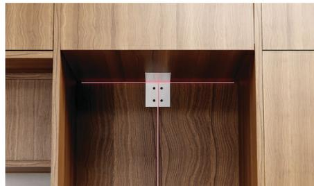
Misurare l'altezza dal pavimento alla parte anteriore della sporgenza e marcare la parete posteriore.
