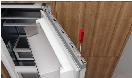
Rimuovere il coperchio superiore usando un cacciavite elettrico. Mettere da parte.
