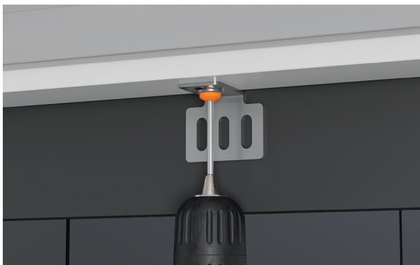
1. Avec la porte ouverte, desserrer la vis du support inférieur. Ajuster le support pour qu'il repose contre le panneau de porte. Resserrer la vis du support.
