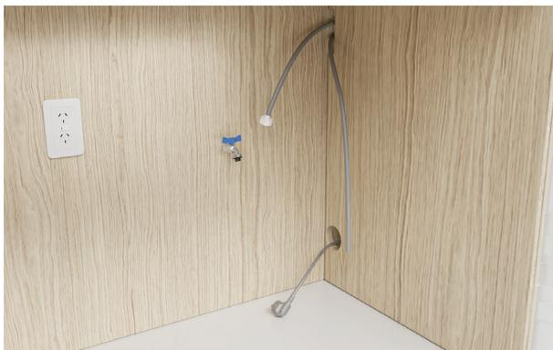
8. 将电源线和软管穿过检修孔。
