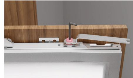
Apriete ligeramente los tornillos laterales y las arandelas M8 superiores con la llave y la llave en L proporcionadas en el kit de instalación.
