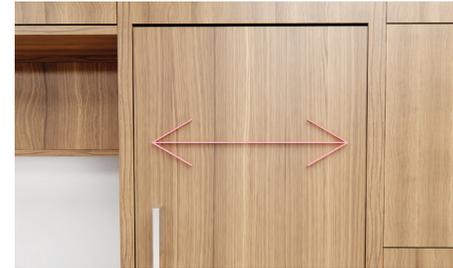
Empuje el panel de lado a lado para ajustarlo horizontalmente. Asegúrese de que los paneles están enrasados con la parte delantera del armario.
