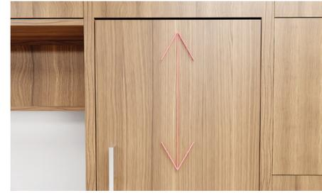
Asegúrese de que los soportes laterales están desacoplados y de que se han aflojado los tornillos de montaje superiores. Gire los vástagos de montaje hacia la derecha para bajar el panel y hacia la izquierda para levantarlo.
