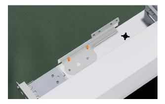
**5.** Para el lado sin bisagras, coloque un nuevo soporte de nicho utilizando tornillos avellanados M6x16.
