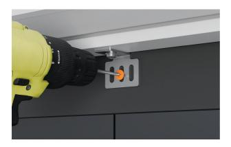
2. Coloque un tornillo adicional a través del soporte para bloquear el panel en su posición.
