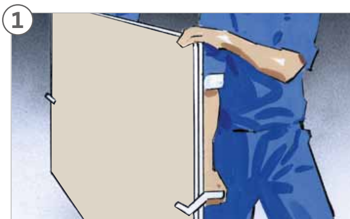
1. Gipsskivorna bärs vertikalt. Bra hjälpmedel är Gyprocs Bärhandtag.
