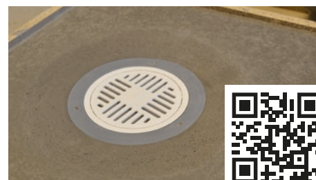
12. Säkerställ korrekt fallbyggnad, tätskikt enligt tätskiktleverantörens anvisning. Se monteringsanvisning för Jafo golvbrunnar för detaljer om montering av klämrings m.m.
