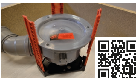
2. Placera golvbrunnen i fixturen. Se monteringsanvisning för golvbrunnsfixturen via QR-kod.
