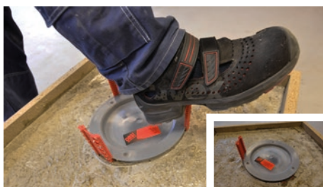
5. När betongen har stelnat, bryt eller slå av de delar av låsarmarna som sticker upp.
