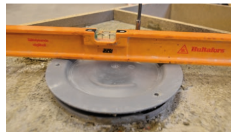
9. Se till att golvbrunnen är i våg. Ovandelen kan vinklas med upp till 4°.
