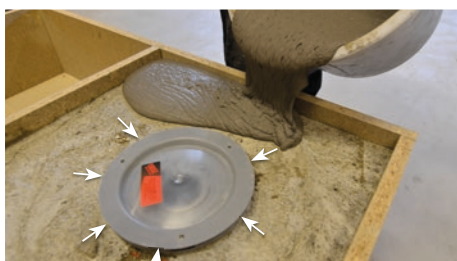
10. Prima golvet samt blanda och lägg på flytspackel enligt spackelleverantörens anvisningar. Säkerställ att flytspackel rinner in mellan fläns och brunn.
