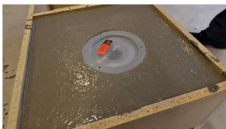
11. Golvlutning mot golvbrunnen ska utföras såväl i underlaget för tätskikt som i ytskiktet. Bakfall får inte förekomma i någon del av utrymmet.
