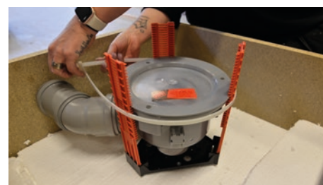
3. Fixera golvbrunnen genom att dra åt spännbandet.
