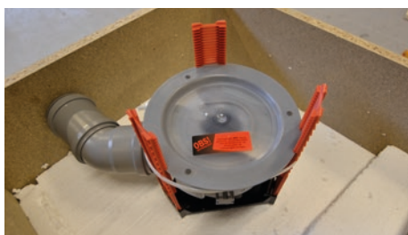
4. Kontrollera att den justerbara delen på golvbrunnen är ihopskruvad i sitt lägsta läge runt om. Klar för gjutning.
