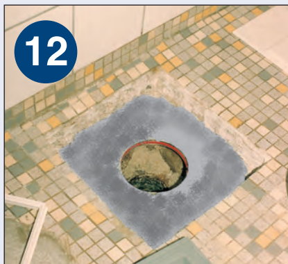
12 Flangen er nu klar til en ny opstøbning.
