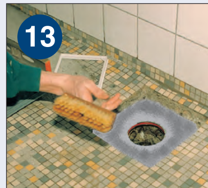
13 Gammel beton fugtes for at sikre en støbebro mellem ny og gammel beton.
