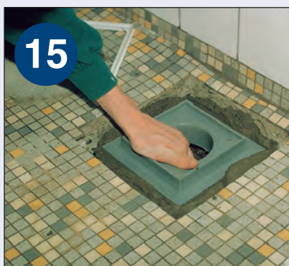
15 Toppen monteres i flangens O-ring og trykkes i betonen med en let vibrering.
