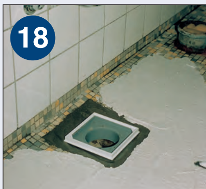
18 Afvent nu betonens færdige afhærdning før afretningslaget påføres.
