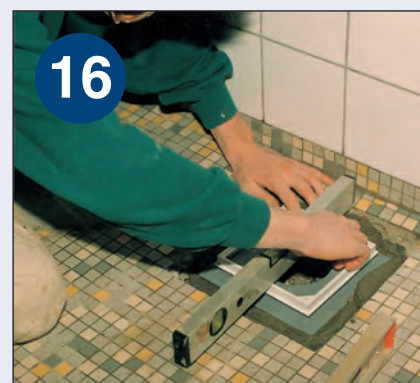
16 Den korrekte gulvhøjde kontrolleres og tilpasses.
