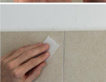
Ennen asennuksen jatkamista puhdista laatat seinäkiinnikkeen asennuskohdasta puhdistusliinalla.
