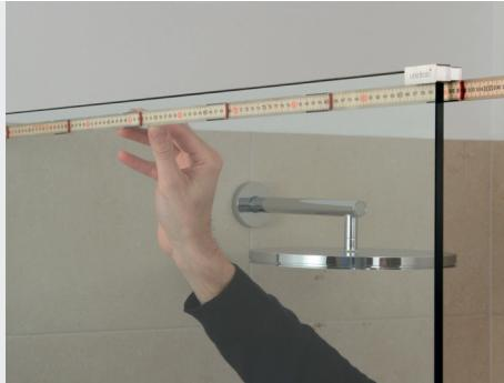
Mittaa suihkuseinän syvys seinäläatoista unidrain®-lasikiinnikkeeseen saakka.
