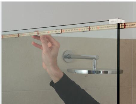
Mål dybden på dusjnisjen fra flisene på veggen til unidrain® glassbeslaget.
