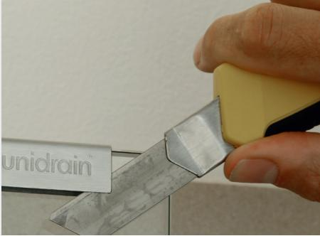
A photograph showing a hand holding a yellow putty knife. The knife is being used to carefully remove a thin layer of silicone sealant that surrounds the "unidrain" logo on the glass. | <p>unidrain® logoen er limt på med silikon. Skjær silikonet forsiktig løs med en hobbykniv (MERK: Pass på at det ikke blir riper i glasset.)</p> |
