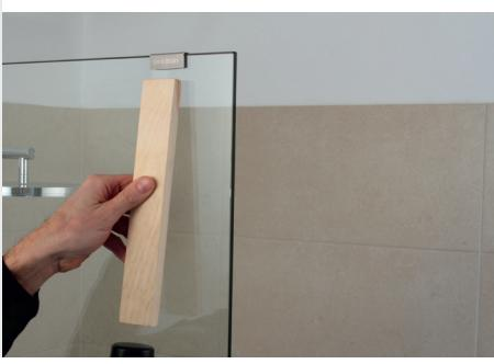
A photograph showing a hand holding a long, thin wooden block. The block is being used to gently tap or lever the small "unidrain" emblem off the glass surface.                       | <p>Når det lille emblemets er skåret løs, kan det enten lirkes av eller slås forsiktig av med en hammer og en trekloss.</p>                      |
