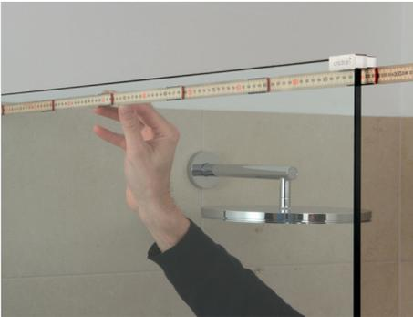
Mål dybden af brusenichen fra fliserne på væggen til unidrain® glasbeslaget.
