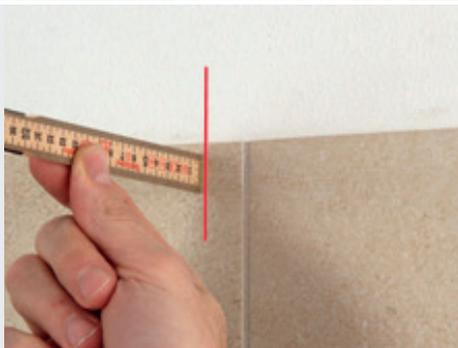
Pomiar należy wykonać dokładnie w miejscu, gdzie przymocowana zostanie górna szyna.
