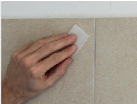
Rens fliserne med en klud, hvor vægbeslaget til topstangen skal sidde, inden de næste trin udføres.
