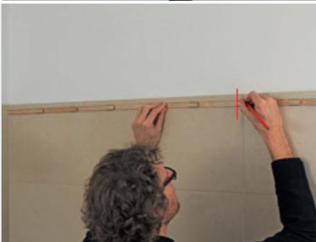
Nanieść oznaczenia na przeciwnej ścianie kabiny prysznicowej.
