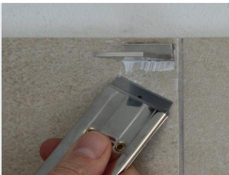
Po odklejeniu bloku piankowego widoczne mogą być wycieki nadmiaru kleju, które należy usunąć skrobakiem lub nożem z tamanym ostrzem.
