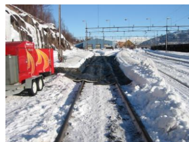
Uptining av järnvägsväxlar för reparation
