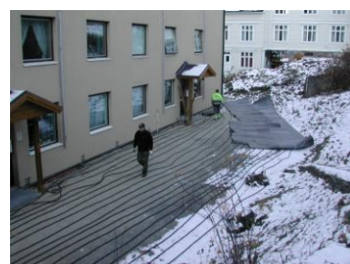
Uptining för grävandet av ny dränering
