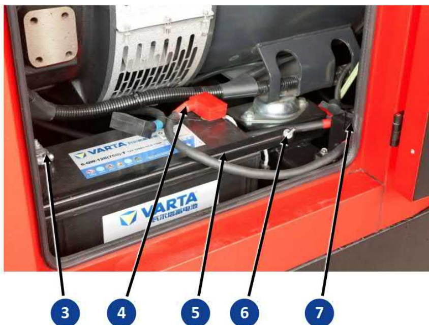
Fig. 10-1 Startbatteri (liknar bilden)
