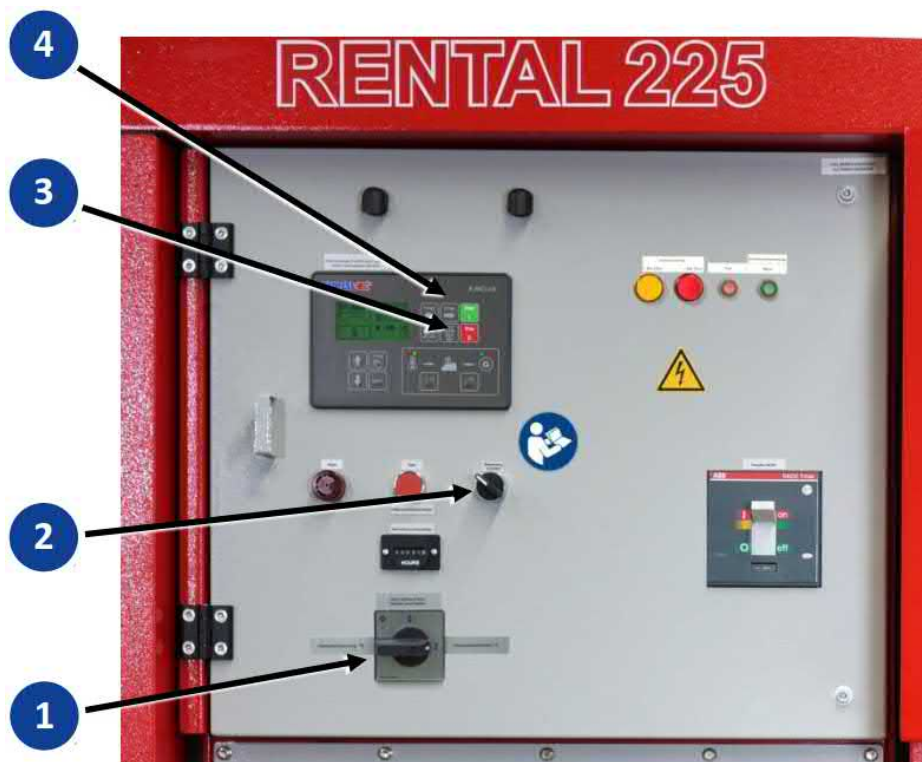
Fig. 7-2 Starta och stoppa generatorm manuellt
