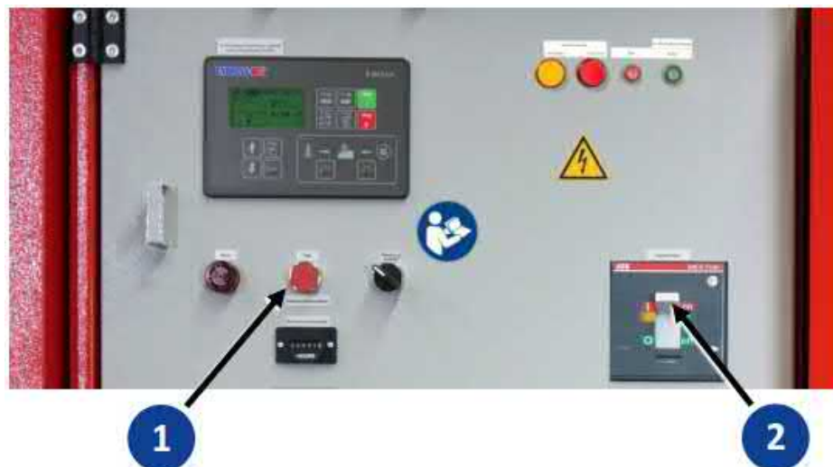
Fig. 7-5 Differentialströmutlösare
