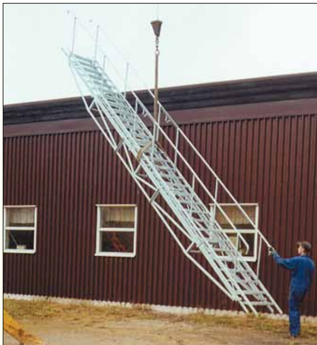
Här är en 30-steps trappa uppställd till ca 7 m höjd. Höjden kan varieras.
