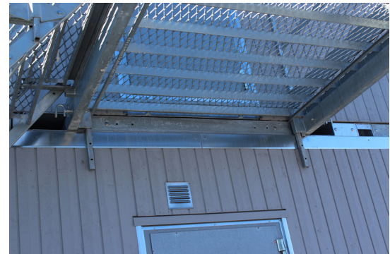
SMIDIG MONTERING, STABIL KONSTRUKTION, FEM-BERÄKNAD ATT TÅLA EN BELASTNING PÅ 2000KG (PLATTFORMEN)
