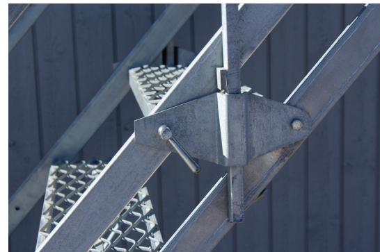
TRAPPAN LÅSES PÅ HELA 8 PUNKTER VILKET GER EN SÄKER "FACKVERKSKONSTRUKTION"
