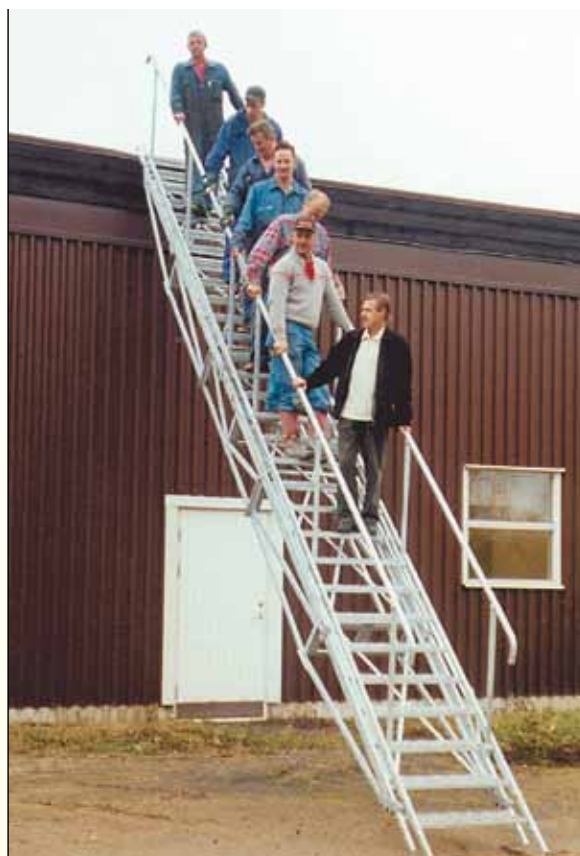
Här är en 30-steps trappa uppställd till ca 7 m höjd. Höjden kan varieras.
