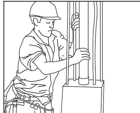
2.- Alsipercha-systemet kan brukes når betongen har nådd 10 % av sin sluttstyrke (basert på minste betongstyrke på 25 N/mm<sup>2</sup>). Når alt formarbeid er ferdig, kan enheten løftes med kran til en annen søyle.
