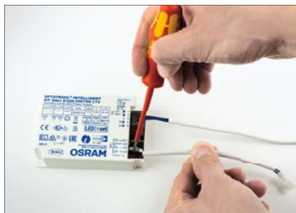
Vaihe 2: Kytke johdot DALI-liitäntälaitteeseen
