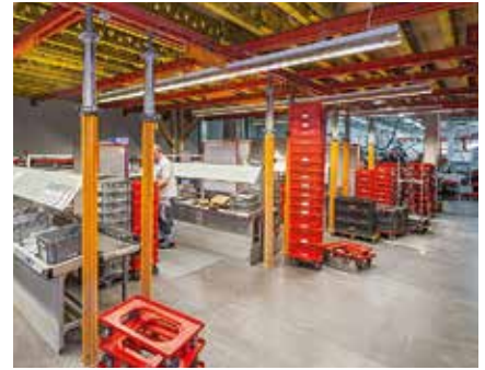
Edullinen tukirakenne koostuu MULTIPROP-tuista ja VARIOKIT-järjestelmäosista.
