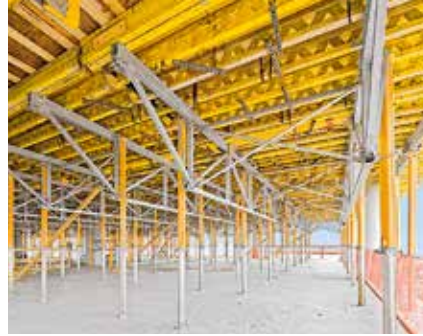
Suurien SKYTABLE-pöytämuottien kanssa käytetyt MULTIPROP-tuet nopeuttavat syklejä ja parantavat turvallisuutta.
