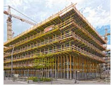
PERI-ratkaisu, jossa käytössä oli MULTIPROP ja MULTIFLEX, toimi sekä parvekkeiden muotituksessa että työtelineenä.
