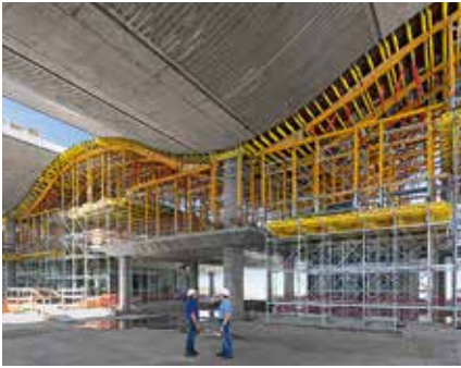
VARIOKIT- ja MULTIPROP-järjestelmäosat muodostavat kustannustehokkaan ratkaisun monimutkaisille muodoille.
