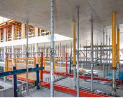
RCS MP -lastaustasojen RCS-kiskot voidaan puristaa MULTIPROP-tuilla kahden kerroksen väliin.
