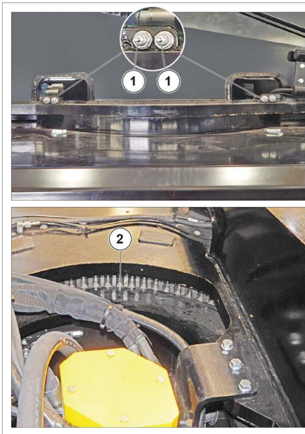
Figur 160: Rengöring och smörjning av tornrotationens femte hjul
