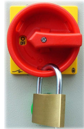
Kuva 58 Pääkytkin varmistettuna
